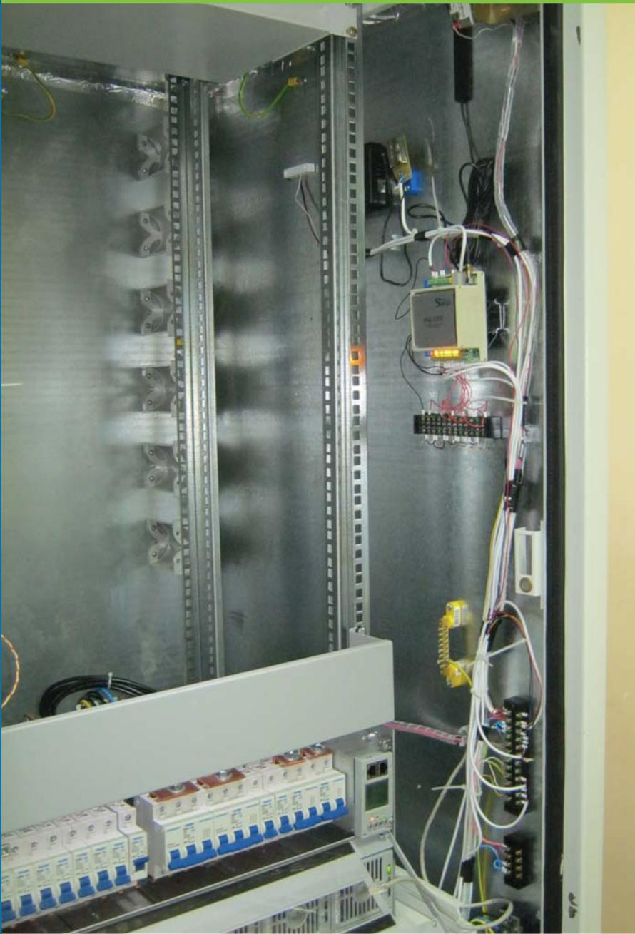
Корпуса для электроники, устанавливаемые на стандартные DIN рейки
